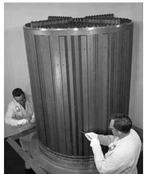
De reactorkern van een experimentele gesmolten zout reactor.
